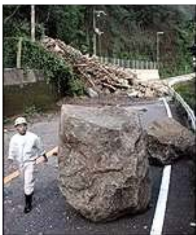
Figura 3. Desprendimientos a causa de un terremoto. Inutilización de la vía de comunicación.
