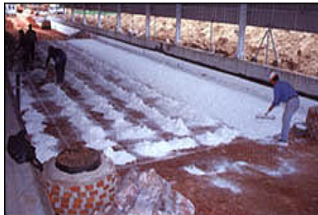
Figura 8. Construcción de una carretera.
