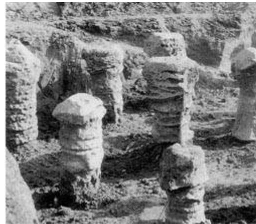
El jet-grouting es un proceso que consiste en la desagregación del suelo (o roca poco compacta), mezclándolo, y parcialmente sustituyéndolo, por un agente cementante (normalmente cemento). La desagregación se consigue mediante un fluido con alta energía, que puede incluir el propio agente cementante.
