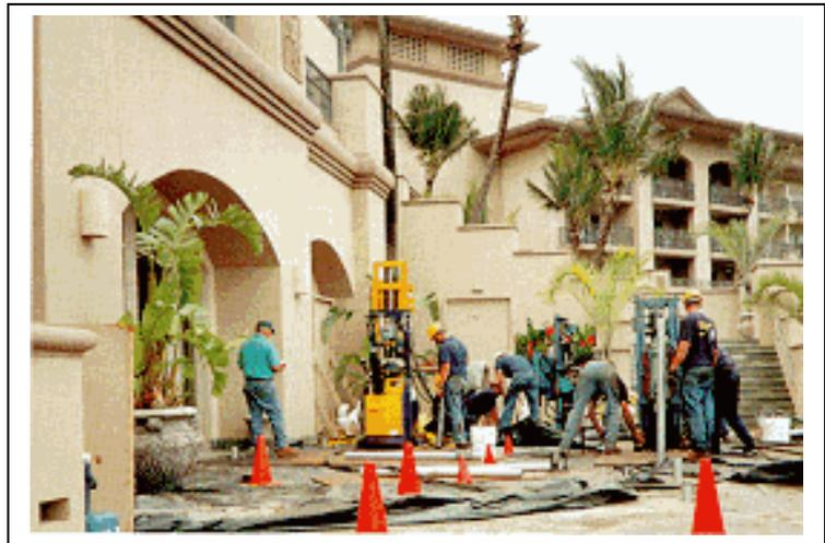
Las cargas admisibles oscilan entre 3 y 150 toneladas. Las cargas se transmiten por fricción y punta, habiéndose obtenido valores máximos en prueba de carga de hasta 350 toneladas.
