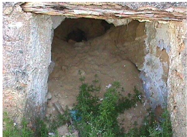
Con el paso del tiempo, y tras persistir esta situación, se produjo el deslizamiento objeto del estudio, que fue causado por el hundimiento generalizado de las galerías.
